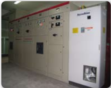
立式安装的AccuSine有源滤波器
